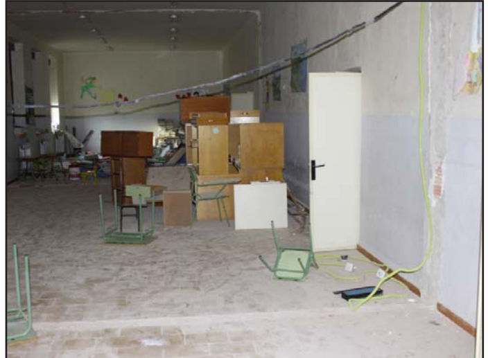
estado de la zona de aulas
