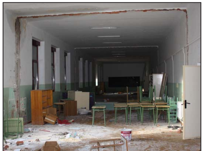
estado general del edificio
